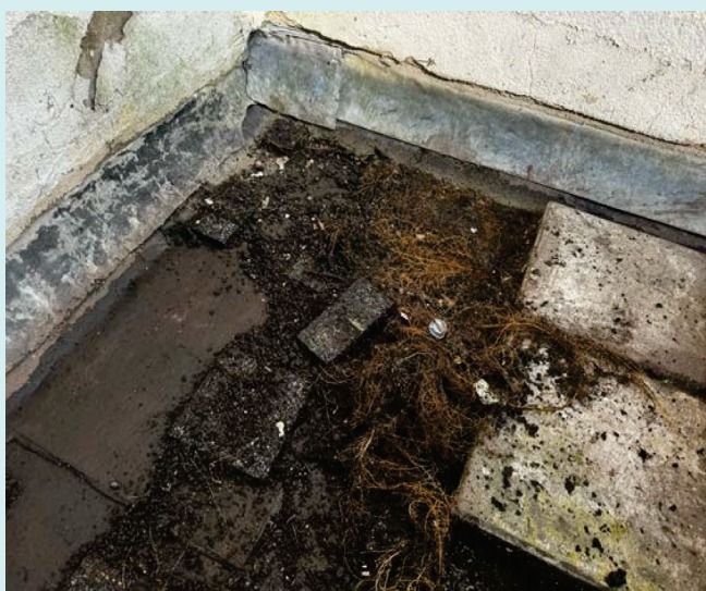
Onderzoek/inspectie van dak door lekkage
