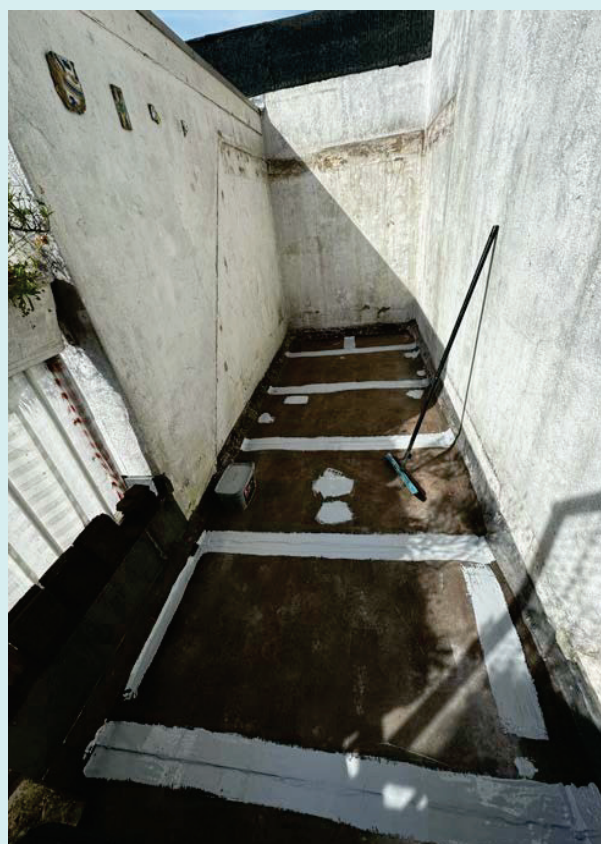
Na reparatie van lekkend dak
